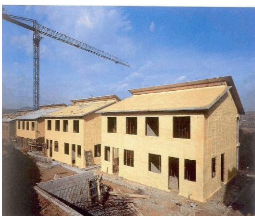
‘Εικόνα 3. Εξωτερική θερμομόνωση’
