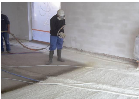
‘Εικόνα 5. Μόνωση Δαπέδου-Ενδοδαπέδια’
