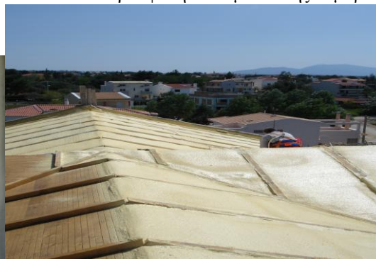
‘Εικόνα 10. Κεκλιμένη και Πολυεπίπεδη οροφή’
