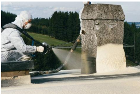
‘Εικόνα 1. Ψεκασμός σε σύναψη’
