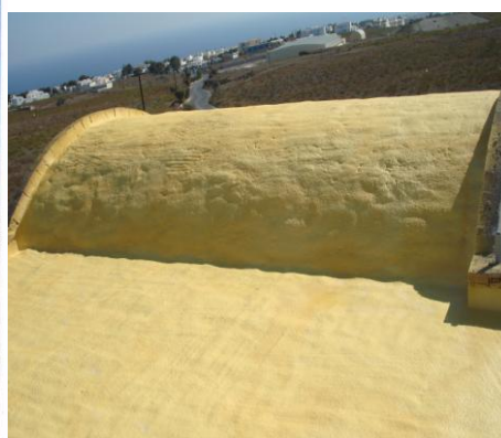
‘Εικόνα 4. Μόνωση σε τρούλο στο Αιγαίο’
