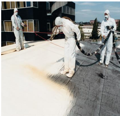
‘Εικόνα 7. Μόνωση Οροφής’
