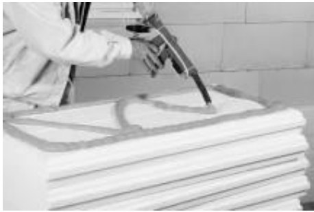
Φωτογραφία 3. Τοποθέτηση του υλικού επικόλλησης με μηχανή
