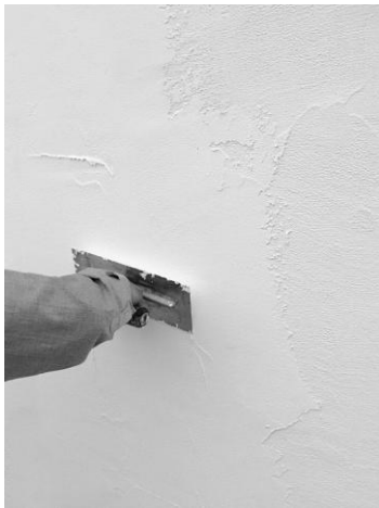
Φωτογραφία 10. Εφαρμογή έγχρωμου τελικού οργανικού επιχρίσματος
