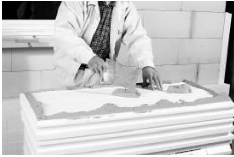
Φωτογραφία 2. Τοποθέτηση του υλικού επικόλλησης με το χέρι
