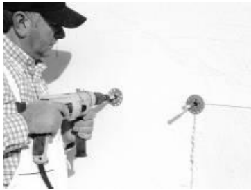
Φωτογραφία 5. Τοποθέτηση βυσμάτων αγκύρωσης
