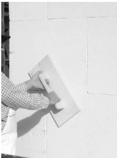
Φωτογραφία 4. Εξομάλυνση των θερμομονωτικών πλακών με τριβίδι
