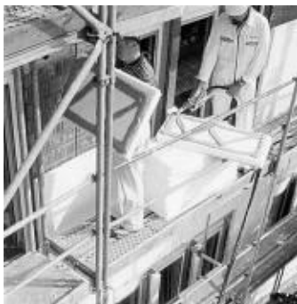
Φωτογραφία 1. Επικόλληση των μονωτικών πλακών
