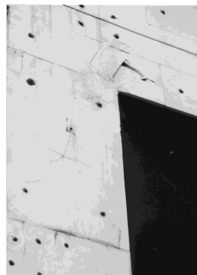
Εικόνα 17. Άστοχη στερέωση.
