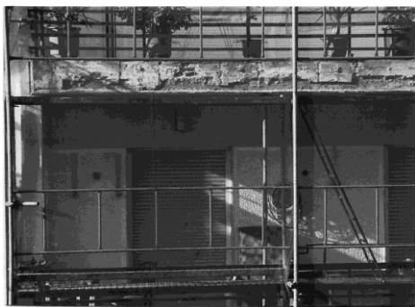
Εικόνα 16. Αποκόλληση πλακών από κούτελα των βεραντών πολυκατοικίας.
