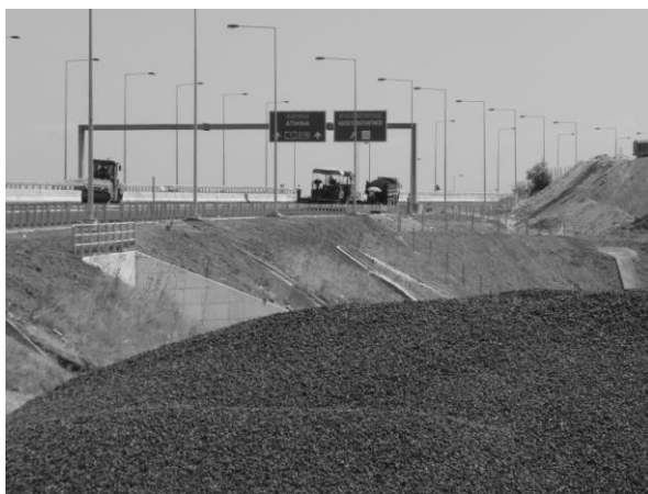
Εικόνα 2. Κατασκευή αντιολισθηρού τάπητα στο πέταλο του Μαλιακού το 2007
