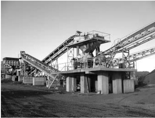
Εικόνα 1. Μονάδα επεξεργασίας σκωρίας ηλεκτρικού κλιβάνου
