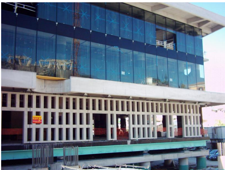
Εικόνα 4. Νέο Μουσείο Ακρόπολης. Προκατ.Εξωτερικά Πανέλα Πρόσοψης Κυρία Είσοδος (Κατασκευή ΠΡΟΕΤ ΑΕ- 2007)
