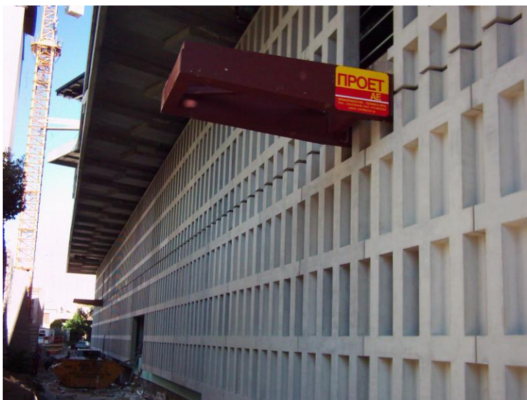
Εικόνα 3. Νέο Μουσείο Ακρόπολης. Προκατ.Εξωτερικά Πανέλα Πρόσοψης Νότια όψη (Κατασκευή ΠΡΟΕΤ ΑΕ- 2007)
