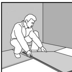
Εικόνα 28. Τοποθέτηση της εξισωτικής πλάκας γυψοσανίδας
