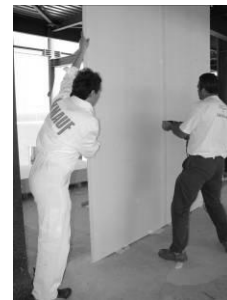
Εικόνα 15. Στερέωση γυψοσανίδων/ ινογυψοσανίδων Vidiwall
