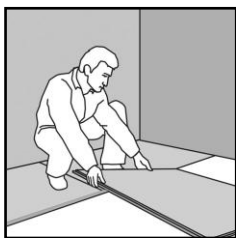
Εικόνα 29. Ξεκινούμε από τη γωνία του δωματίου εναποθέτοντας τη πλάκα κάθετα στους πλευρικούς τοίχους.
