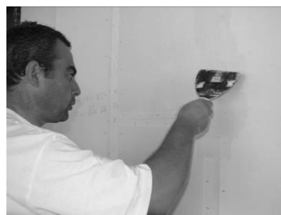
Εικόνα 17. Στοκάρισμα των αρμών με Knauf-Uniflott και χαρτοταινία.
