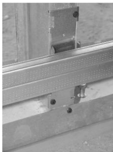
Εικόνα 10. Στερέωση οριζόντιας τραβέρσας στο ειδικό κλιπ
