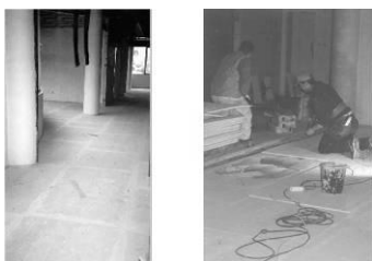
Εικόνα 22. Εφαρμογή δαπέδων Vidifloor στο εργοτάξιο
