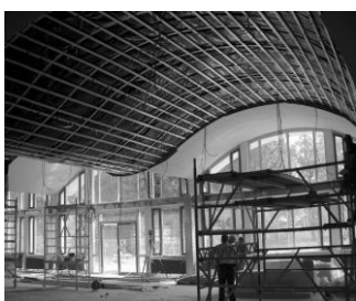
Εικόνα 36. Διαμόρφωση καμπύλων οροφών με διάτρητες γυψοσανίδες
