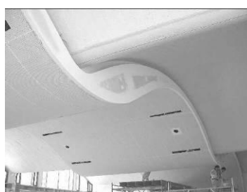
Εικόνα 36. Διαμόρφωση καμπύλων οροφών με διάτρητες γυψοσανίδες
