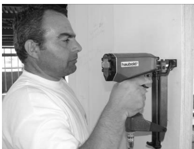
Εικόνα 16. Κάρφωμα των εξωτερικών στρώσεων ινογυψοσανίδας Vidiwall με μεταλλικά δίχαλα
