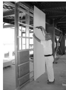
Εικόνα 14. Στερέωση γυψοσανίδων/ ινογυψοσανίδων Vidiwall
