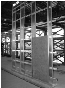
Εικόνα 13. Τοποθέτηση μονωτικού υλικού
