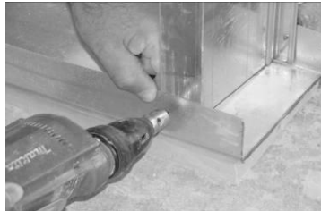
Εικόνα 8. Στερέωση του ορθοστάτη μέσα στον στρωτήρα
