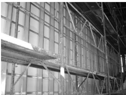
Εικόνα 6. Κατασκευή τοίχου GH- Acoustique 34/432
