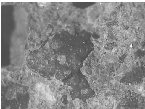
Εικόνα 4. Καλή πρόσφυση αδρανών σκωρίας-τσιμεντόπαστας
