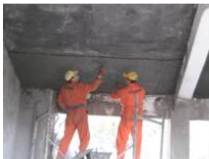
Σχήμα 1. Η πρώτη εφαρμογή των Ινοπλεγμάτων Ανόργανης Μήτρας σε πραγματικό έργο: (α) ενίσχυση πλάκας οπλισμένου υσκυροδέματος, (β) ενίσχυσης φέρουσας τοιχοποιίας.
