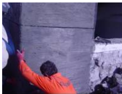
Σχήμα 1. Η πρώτη εφαρμογή των Ινοπλεγμάτων Ανόργανης Μήτρας σε πραγματικό έργο: (α) ενίσχυση πλάκας οπλισμένου υσκυροδέματος, (β) ενίσχυσης φέρουσας τοιχοποιίας.
