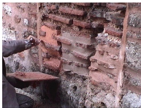
Καθαρισμός και προετοιμασία της τοιχοποιίας πριν την εφαρμογή. Εφαρμογή των κονιαμάτων στην τοιχοποιία
