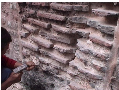
Καθαρισμός και προετοιμασία της τοιχοποιίας πριν την εφαρμογή. Εφαρμογή των κονιαμάτων στην τοιχοποιία
