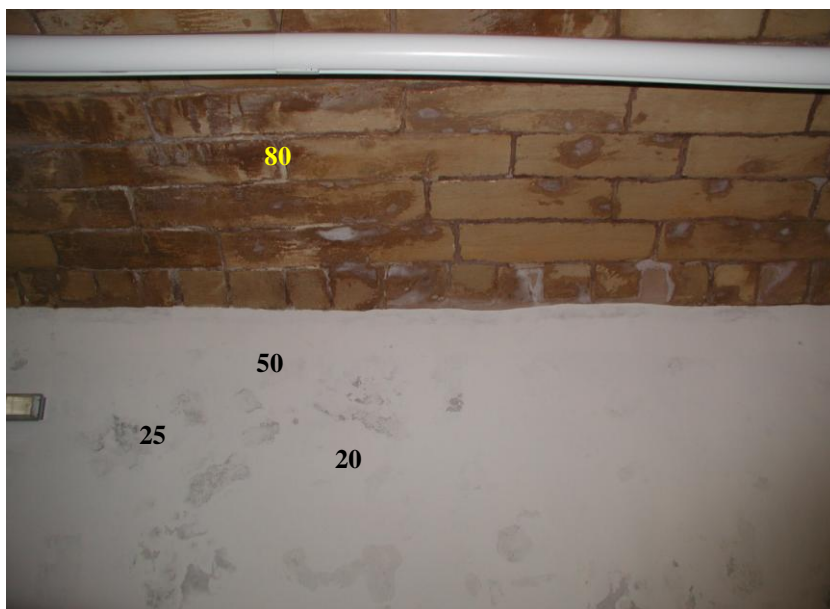
Εικόνα 4. Ισόγειο, ανατολική αίθουσα, βόρειο τόξο δυτικού τοίχου. Λεπτομέρεια από τον θόλο με την παρουσία αλάτων και τις % τιμές της υγρασίας.
