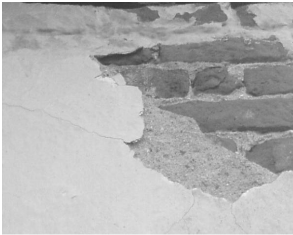
Εικόνα1. Αποκολλήσεις επιχρισμάτων από υγρασία
