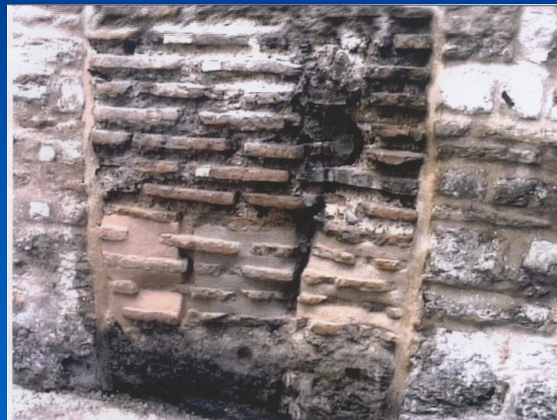
Η τοιχοποιία μετά την Πιλοτική Εφαρμογή κονιαμάτων αποκατάστασης
