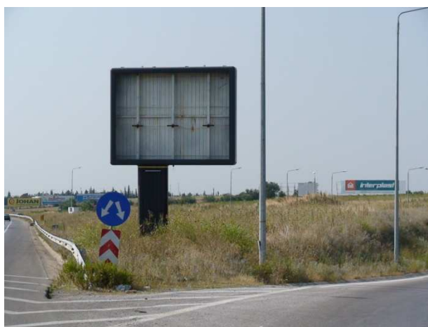
Εικόνα 1. Διαφημιστική πινακίδα σε πλευρική νησίδα ανισόπεδου κόμβου Photograph 1. Billboard in exit ramp of interchange
