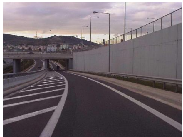
Φωτογραφία 6. Επιφάνεια αποκλεισμού για τοποθέτηση ακουστικών λωρίδων Picture 6. Surface where traffic is prohibited (the use of tactile markings is proposed)
