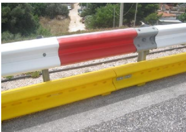
Φωτογραφίες 10 και 11. Πρόσθετη λεπίδα στο στηθαίο για προστασία μοτοσυκλετιστών Pictures 10 & 11. Secondary rail to protect motorcyclists
