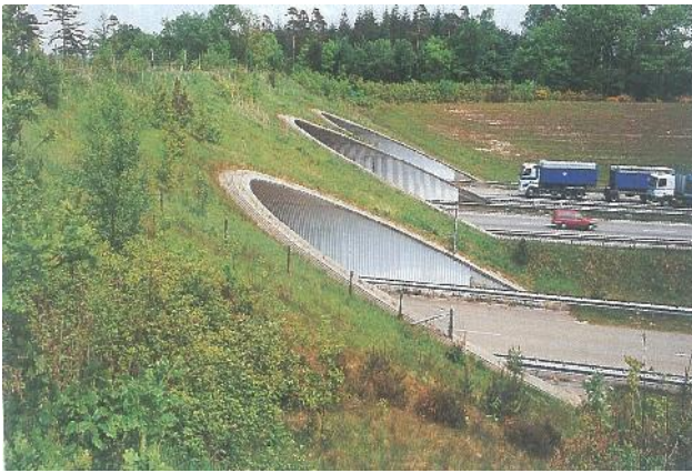
Εικόνα 2. Αισθητική αποκατάσταση του στομίου σήραγγας cut & cover Photograph 2. Aesthetic restoration of the outlet of cut&cover
