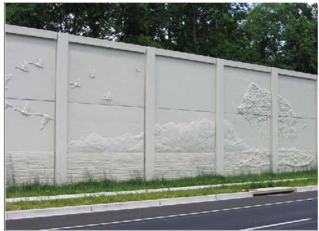
Εικόνα 3. Ηχοπέτασμα με ανάγλυφη παράσταση Photograph 3. Noise barrier with sculptured surface
