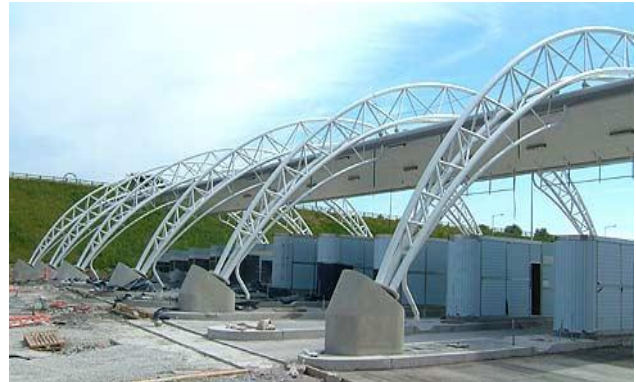
Εικόνα 9. Σταθμός διοδίων υπό κατασκευή Photograph 9. Toll station under construction
