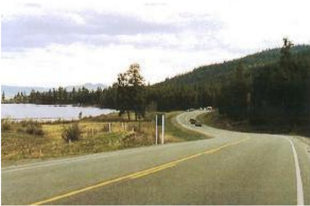
Εικόνα 1. Προσαρμογή της γεωμετρίας στην υπάρχουσα τοπογραφία. Photograph 1. Adaptation of geometry design in topography
