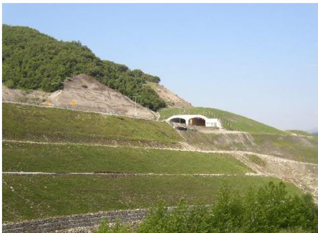
Εικόνα 5. Σήραγγα cut & cover στην Εγνατία Οδό
