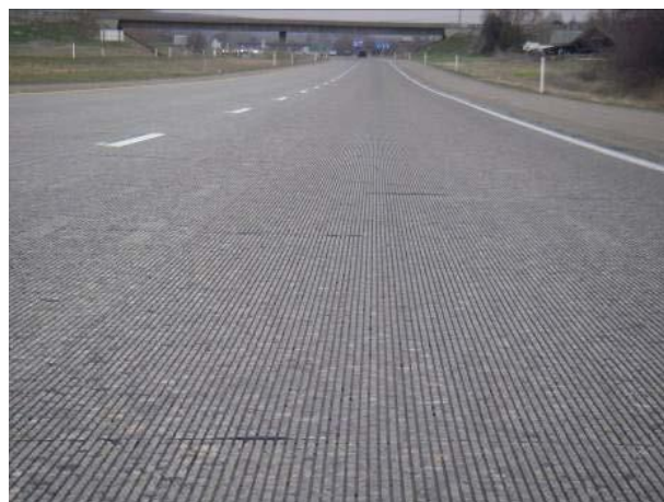
Εικόνα 6. «Ήσυχο» δύσκαμπτο οδοστρώμα νέας γενιάς Figure 6. Next generation quite concrete pavement.
