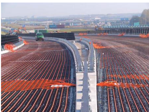
Εικόνα 4. Σύστημα ηλιακού συλλέκτη σε σε γέφυρα στο Rotterdam, Ολλανδία. Figure 4. Asphalt solar collector on a bridge in Rotterdam, Netherlands.
