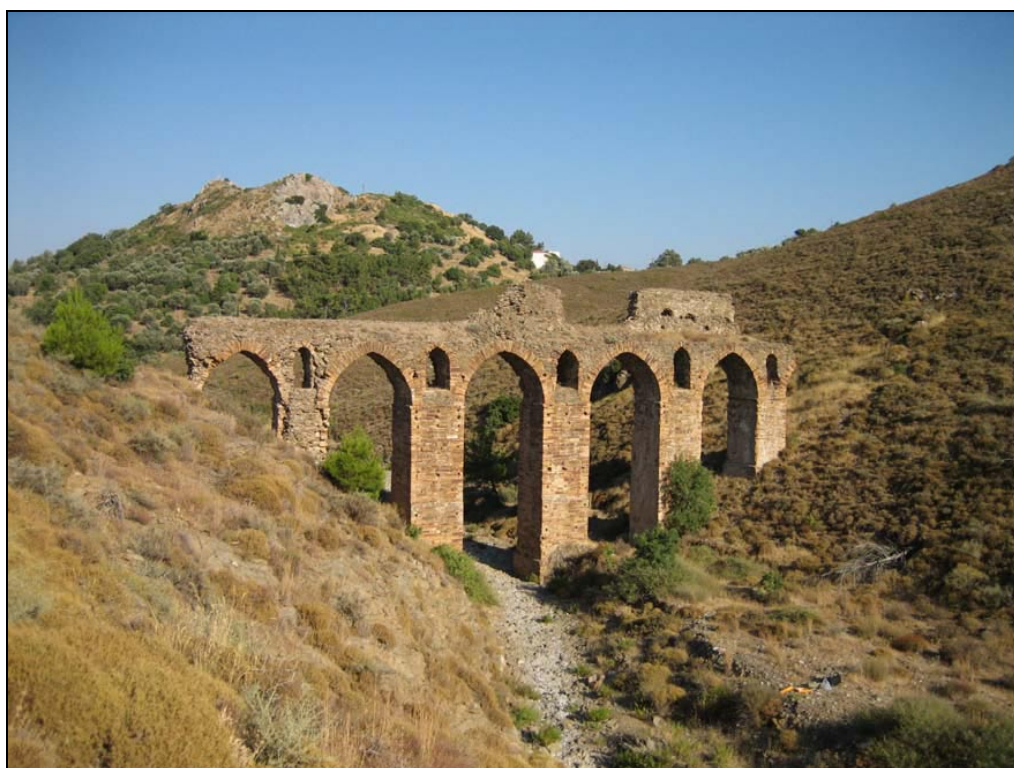
Εικόνα 1. Η υδρογέφυρα πάνω από τον χείμαρρο Κουφό. Στο βάθος το ύψωμα του Λατομιού
