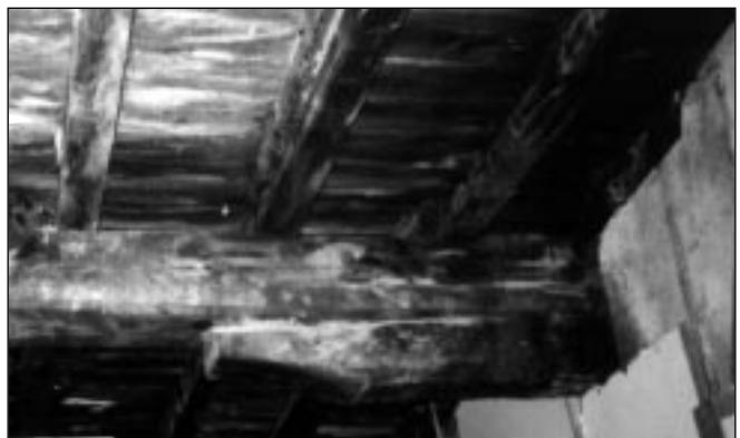
Εικόνα 2: Ιστορικό κτίριο «Καλογερικό» στη Θάσο, Λιμένα (αρχείο 4ης ENM, φωτογρ.: A. Μέντζα). Πολύ προσεγμένη κατασκευή, (μερική) πάκτωση δοκού.
