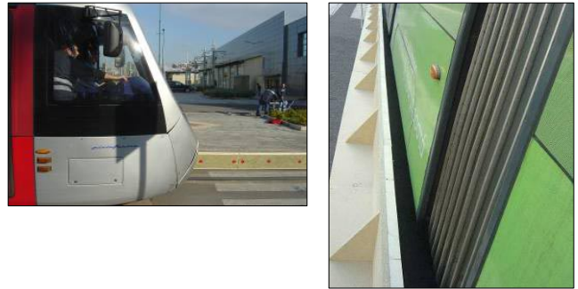
Σχήμα 3 : Ηχο-απορροφητικό αντιθορυβικό πέτασμα χαμηλού ύψους στο Αμαξοστάσιο της ΤΡΑΜ Α.Ε. στο Ελληνικό.
