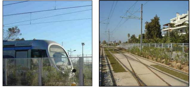
Σχήμα 2 : Διαφανές αντιθορυβικό πέτασμα μεσαίου ύψους στην οδό Διαδόχου Παύλου.
