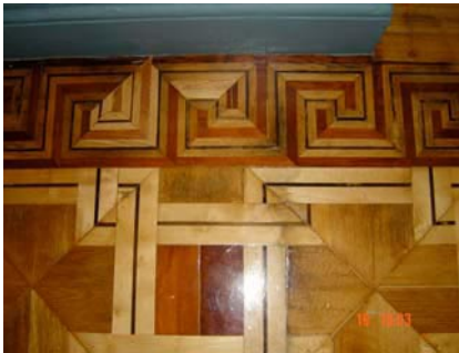
Το αρχικό δάπεδο μετά την αποκάλυψη και τη συντήρησή 24 .
