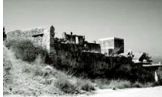
Εικ. 3: Ριφάν Μετόχι κοντά στο Ρέθυμνο.
