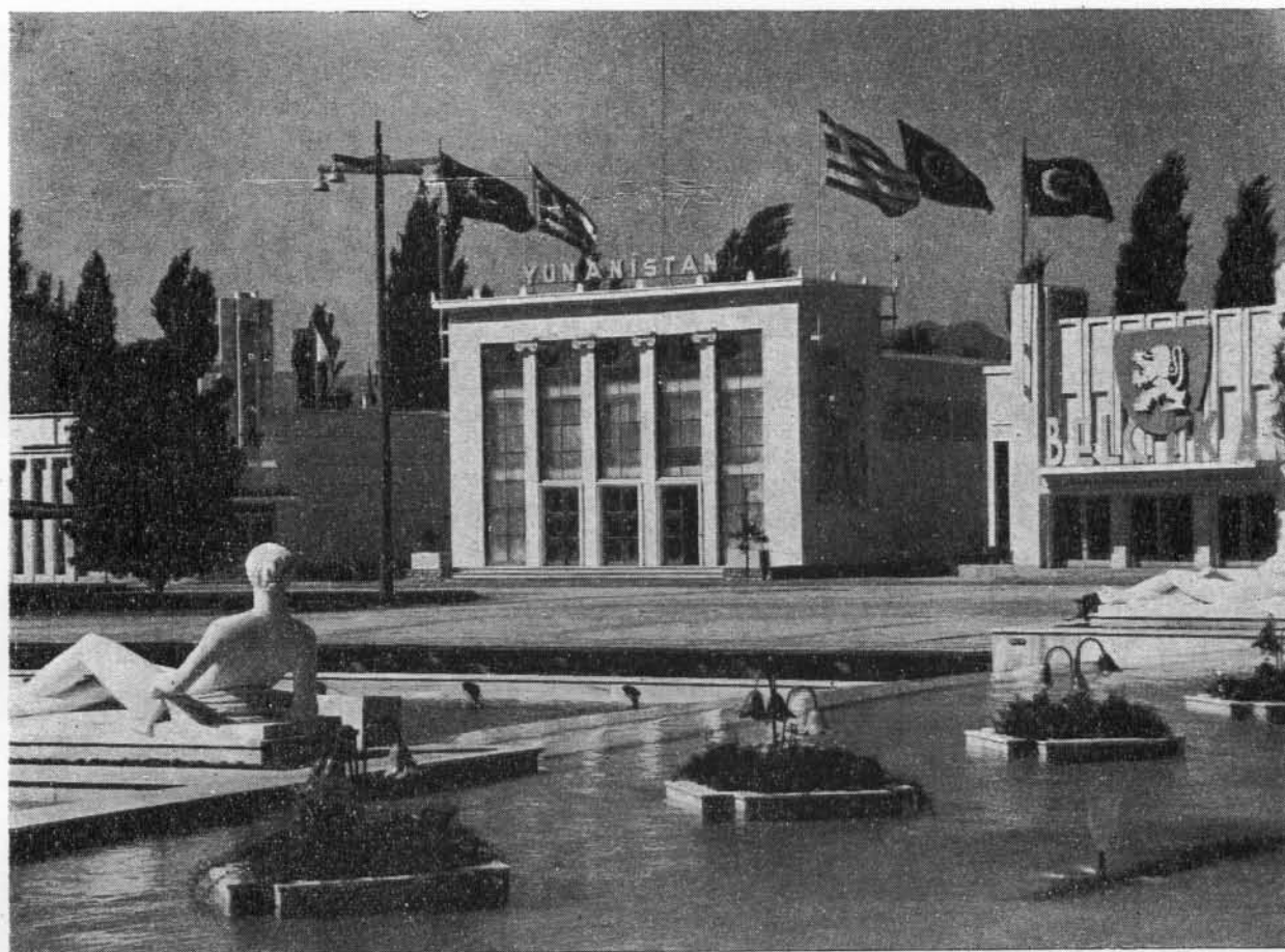
Εικών 8. Έκθεσις Σμύρνης 1953. Τό νέον μόνιμον ἑλληνικόν περίπτερον κατεσκευάσθη μέ σκελετόν ἐκ μπετόν-ἀρμέ καί σιμεντολίθων. Ἐίς τό ἔμπροσθεν τμήμα ὑπάρχει βοηθητική αἴθουσα ἐκθέσεων εἰς τόν 1ον ὄροφον καί ἐγκατάστασις γραφείων τῆς ὑπηρεσίας εἰς τόν 2ον.
