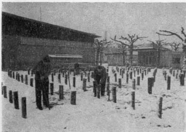
Είκονες 3, 4. Πώς όρχίζουσι να κατασκευάζωνται τά περίπτέρα. Άριστερά, επί ένός χιονοσκεπούς οικόπεδου, θεμελίωσις επί ξυλίνων πασσάλων του περιπτέρου Φραγκφούρτης 1952 και δεξιά ό παραχωρούμενος χώρος, έντός μεγάλου ύποστέγου, διά τήν κατ' έτος έγκατάστασιν του Έλλην. Περιπτέρου εις τήν Έκθεσιν Παρισίων (1952,53,54,55).
