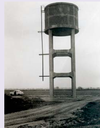
Υδατόπυργος, 100 μ., Φαλάνης Σύνδεσμος Ύδρευσεως Τιρνάβου
