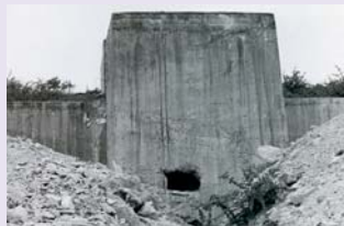
Έργο Συνδέσμου Ύδρευσης Ελευθέρων - Δεξαμενή αποθηκεύσεως Κοιν. Μάνδρας
