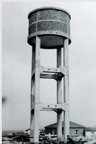
Έργο Συνδέσμου Ύδρευσης Ελευθέρων - Υδατόπυργου Κοιν. Μεσορράχης
