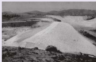
Φράγμα Μεγάλου Ελευθεροχωρίου Λαρίσης
