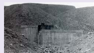
Έργο Συνδέσμου Ύδρευσης Ελευθέρων - Δεξαμενή αποθηκεύσεως ύδατος Κοιν. Αμυγδαλάς
