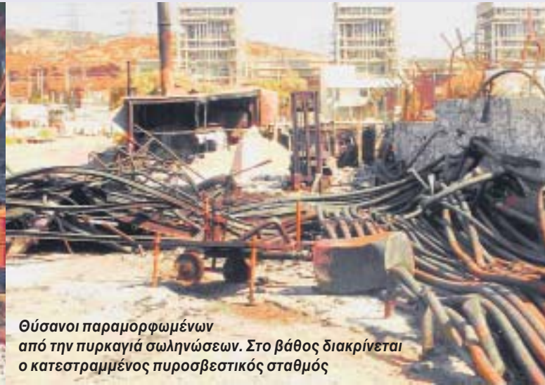
Ο χώρος του γεμιστηρίου μετά την πυρκαγιά. Διακρίνονται παραμορφωμένες σωληνώσεις και διογκωμένα βαρέλια
