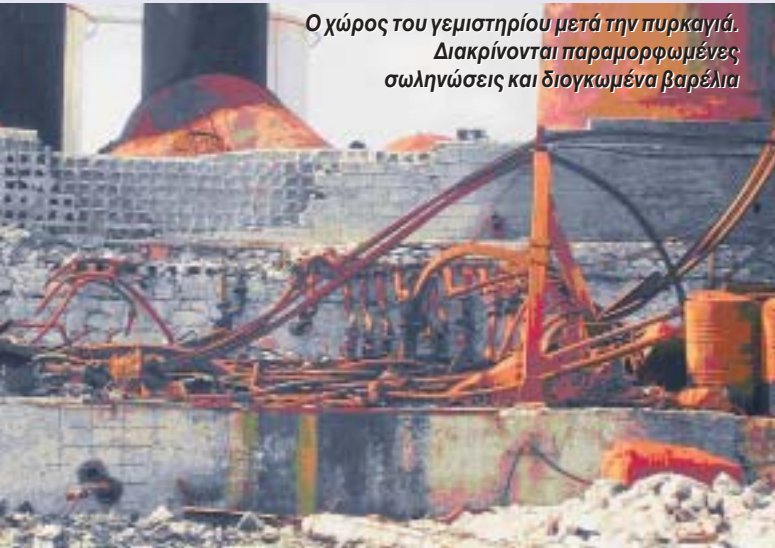
Θύσανοι παραμορφωμένων από την πυρκαγιά σωληνώσεων. Στο βάθος διακρίνεται ο κατεστραμμένος πυροσβεστικός σταθμός
