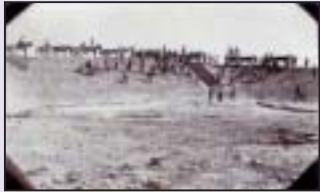
Γενική άποψη της δεξαμενής φορτίσεως από το εσωτερικό κατά την κατασκευή της, 1936 (αρχείο Γ.Η. Παπάζογλου)
