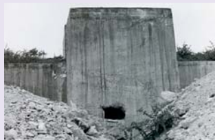
Έργο Συνδέσμου Ύδρευσης Ελευθέρων - Δεξαμενή αποθηκεύσεως Κοιν. Μάνδρας
