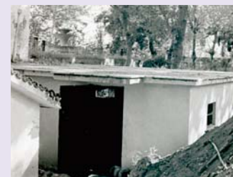
Έργο Συνδέσμου Ύδρευσης Ελευθέρων - Αντλιοστάσιο
