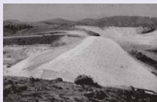
Φράγμα Μεγάλου Ελευθεροχωρίου Λαρίσης
