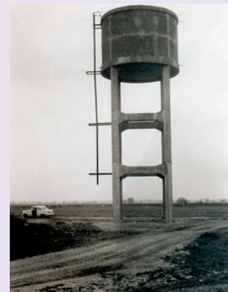
Υδατόπυργος, 100 μ., Φαλάνης Σύνδεσμος Ύδρευσεως Τιρνάβου
