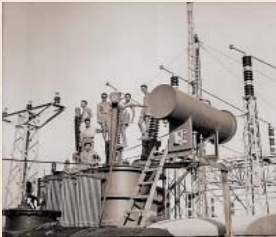
Υποσταθμός της ΔΕΗ υπό κατασκευή Metz and Mac Lelland
