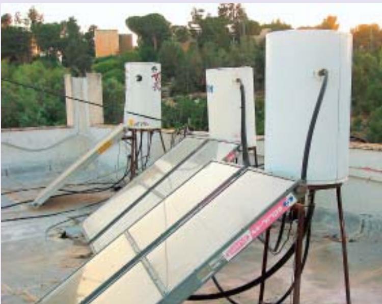
Ηλιακοί θερμοσίφωνες σε ταράτσα πολυκατοικίας στην πόλη της Ιερουσαλήμ
