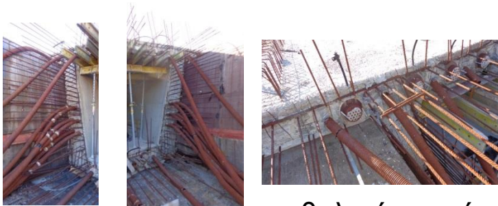
παθολογία φορέα καταστρώματος γέφυρας
