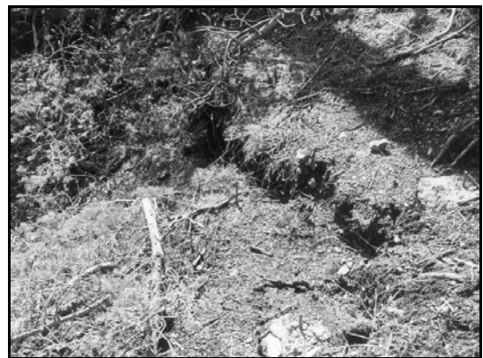
Εικόνες 4 & 5 : Ρωγμές επί του φυσικού εδάφους στο υψηλότερο τμήμα του αντερείσματος
