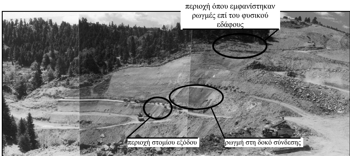
Εικόνα 3 : Πρανές εκσκαφής και υψηλότερο τμήμα του αντερείσματος υπεράνω του στομίου εξόδου της σήραγγας εκτροπής & υπερχειλιστή.
