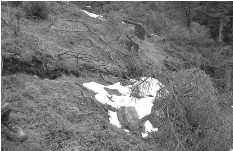
Εικόνα 8. Ρωγμή επί του φυσικού εδάφους στο αντέρεισμα νοτιοδυτικά της εκσκαφής του υπερχειλιστή
