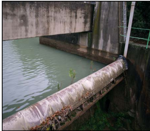
Εικόνα 9β. Αυτόματο θυρόφραγμα με αντίβαρο
