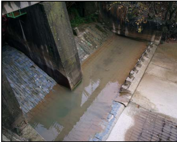
Εικόνα 10. Λεκάνη κατάντη των θυροφραγμάτων
