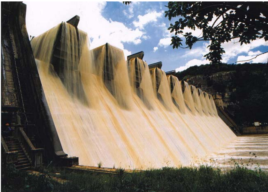
Εικόνα 3. Μεταλλικά ανατρεπόμενα θυροφράγματα (fusegate) τύπου λαβύρινθου σε λειτουργία
