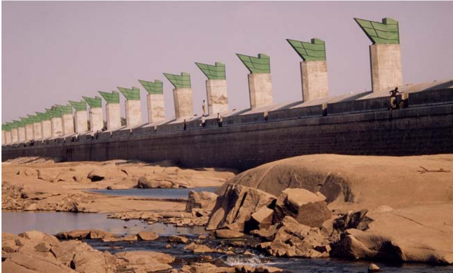
Εικόνα 2. Ανατρεπόμενα θυροφράγματα (fusegate) από σκυρόδεμα
