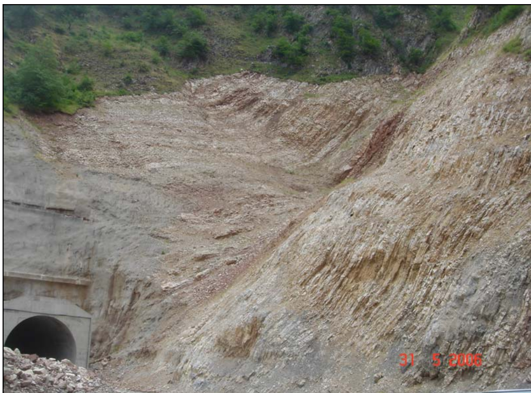
Εικόνα 8: ΥΗΕ Μεσοχώρας. Μέτωπο προς το φράγμα της οδικής σήραγγας προσπέλασης
