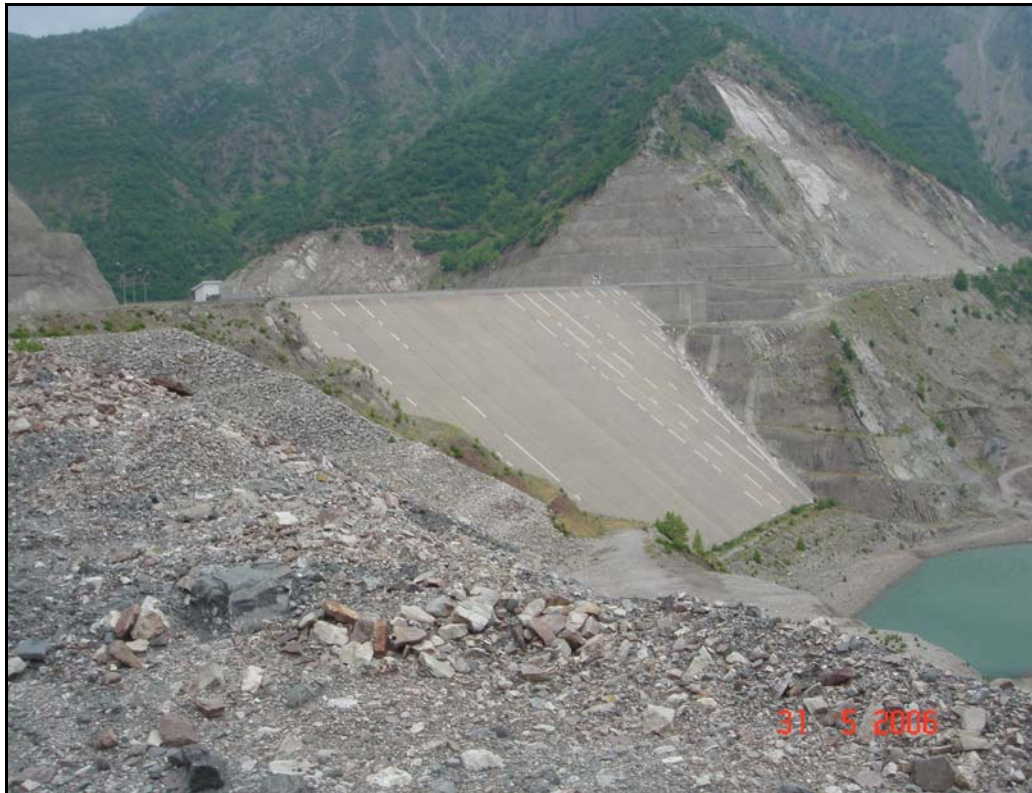
Εικόνα 7: ΥΗΕ Μεσοχώρας. Όψη από ανάντη του ολοκληρωμένου φράγματος
