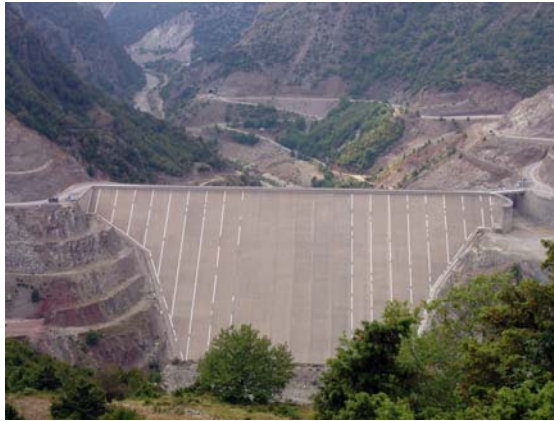
Εικόνα 1: Ανάντη όψη του φράγματος
