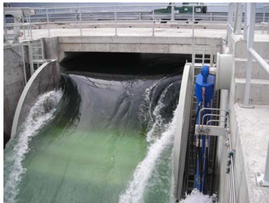
Εικόνα 11: Εκχειλιστής Αναρρύθμισης κατά την κατασκευή και κατακλινόμενο θυροφράγμα σε λειτουργία
