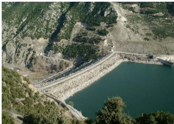
Εικόνα 3: Φράγμα ΥΗΕ Πολυφότου
