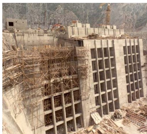
Εικόνα 5: Έργο εκτόξευσης Εκχειλιστή ΥΗΕ Σφηκιάς και Υδροληψίες ΥΗΣ Σφηκιάς
