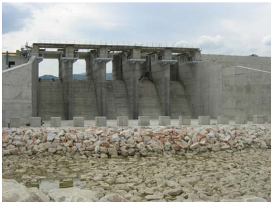
Εικόνα 11: Εκχειλιστής Αναρρύθμισης κατά την κατασκευή και κατακλινόμενο θυροφράγμα σε λειτουργία
