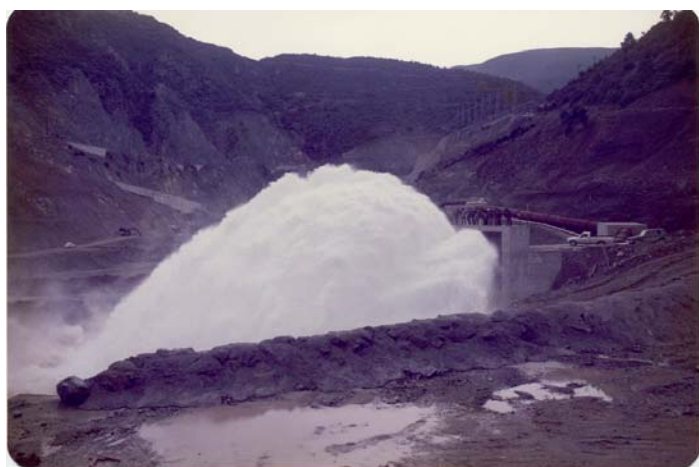
Εικόνα 5: Έργο εκτόξευσης Εκχειλιστή ΥΗΕ Σφηκιάς και Υδροληψίες ΥΗΣ Σφηκιάς
