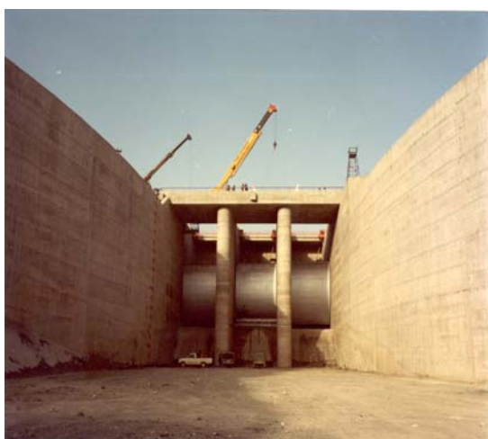
Εικόνα 8: Εκχειλιστής ΥΗΕ Ασωμάτων και Υδροληψίες ΥΗΣ Ασωμάτων
