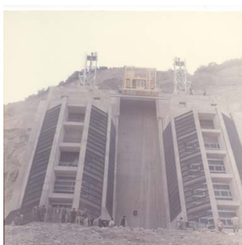
Εικόνα 8: Εκχειλιστής ΥΗΕ Ασωμάτων και Υδροληψίες ΥΗΣ Ασωμάτων
