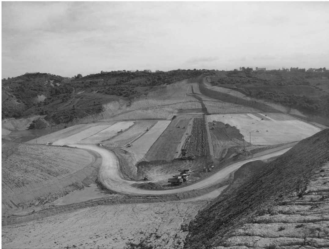
Εικόνα 7: Φράγμα Douera. Πανοραμική όψη της κατασκευής του φράγματος την 15η Φεβρουαρίου 2008
