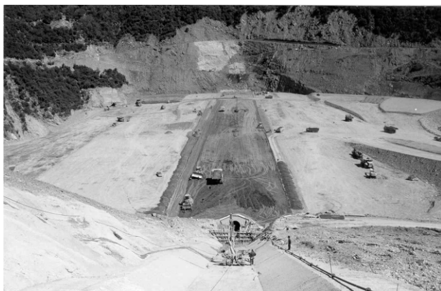
Φωτογραφία 1: Κατασκευή της στοάς τσιμεντενέσεων και του αναχώματος
