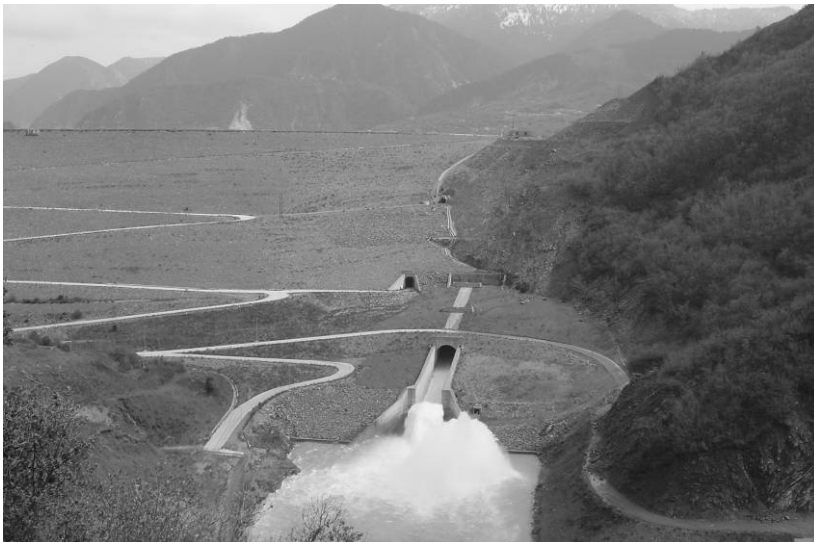
Φωτογραφία 3: Λειτουργία υπερχειλιστή και οικολογικής παροχής.
