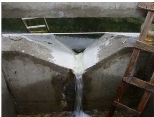
Εικόνα 9: Μέτρηση διαρροών στα κατάντη
