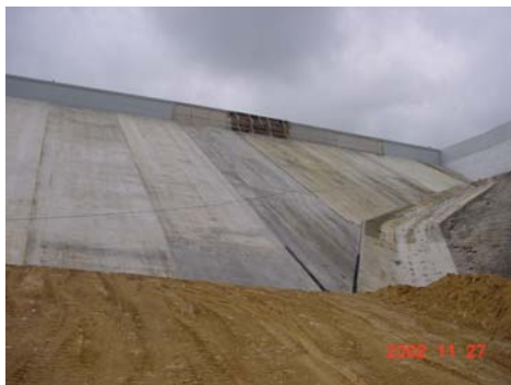
Εικόνα 6: Το φράγμα Παναγιώτικο στη φάση κατασκευής.
