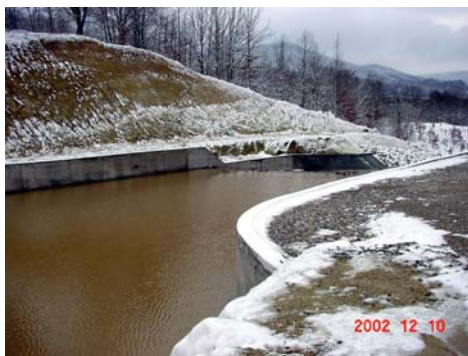
Εικόνα 2 : Εκχειλιστής στη νέα θέση
