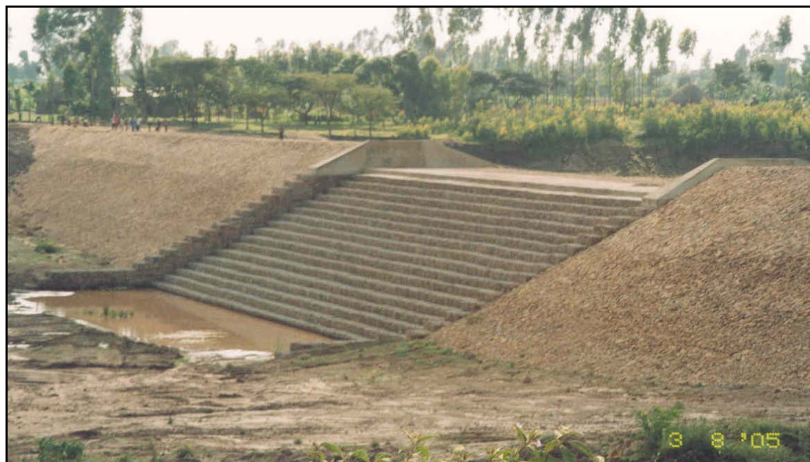
Εικόνα 5. Ολοκληρωμένο φράγμα Damte - Ανάχωμα και υπερχειλιστής
