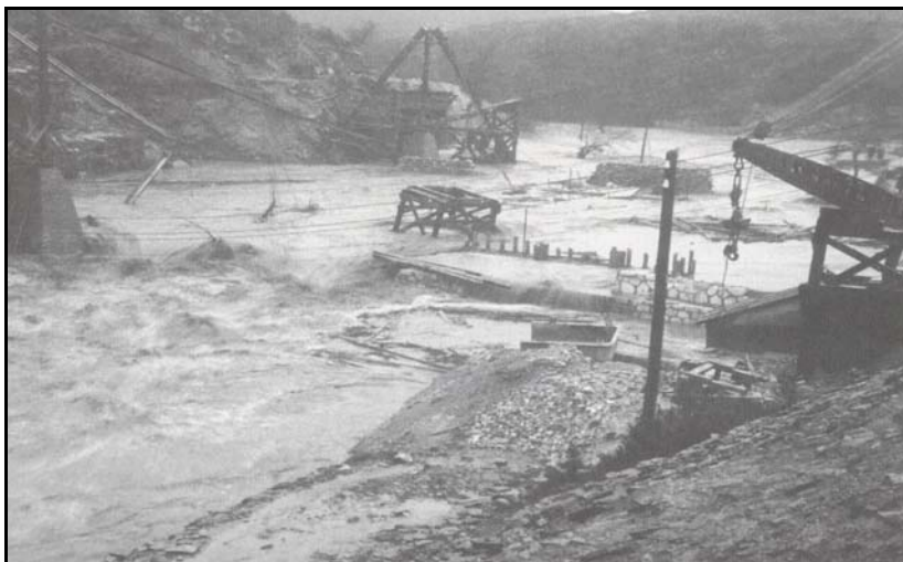
Εικόνα 8. Φράγμα Μαραθώνα. Υπερπήδηση προφράγματος και κατάκλυση περιοχής θεμελίωσης φράγματος - Φωτογραφία από αρχείο ΕΥΔΑΠ {8}
