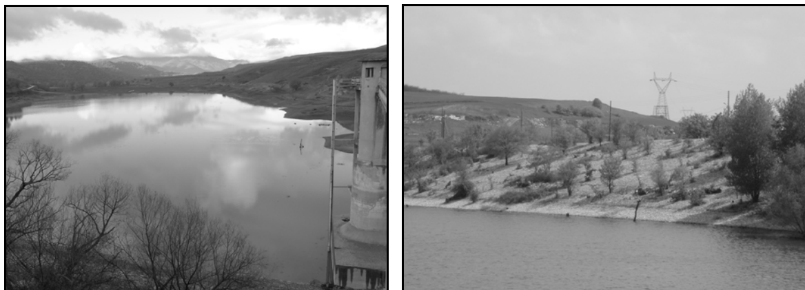
Εικόνα 2. Ταμιευτήρας φράγματος Περδίκας, στη συνήθη στάθμη. Διακρίνεται δεξιά ο πύργος υδροληψίας. Εικόνα 3. Ανάντη όψη φράγματος με ανάπτυξη βλάστησης στο πρανές του αναχώματος.
