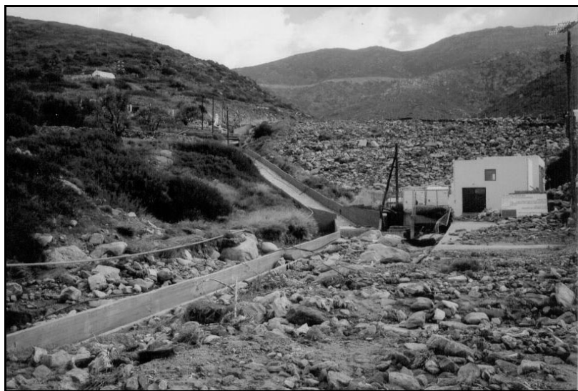
Εικόνα 7. Κατάντη όψη φράγματος μετά το ατυχές συμβάν και υλικά που διαβρώθηκαν και παρασύρθηκαν.
