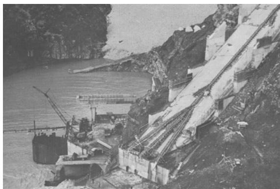
Εικόνα 9. Φράγμα Κρεμαστών. Υπερπήδηση κατάντη προφράγματος - Κατάκλυση σταθμού παραγωγής Εικόνα 10. Φράγμα Κρεμαστών Αποκατάσταση κατάντη προφράγματος με πασσαλοσανίδες
