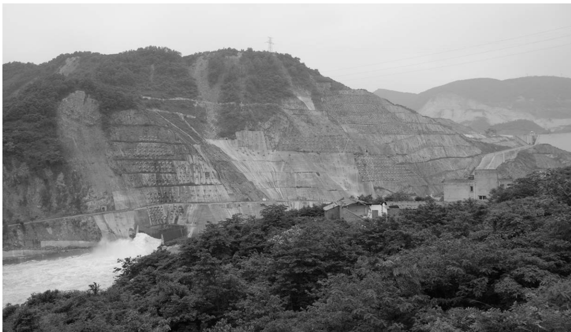
Εικόνα 13: Άποψη του δεξιού κατάντη πρανούς του φράγματος στο οποίο ευρίσκονται ο υπερχειλιστής, το εργοστάσιο ηλεκτρικής ενέργειας και η έξοδος του εκκενωτή πυθμένα που έχει τεθεί σε λειτουργία. Διακρίνονται τα εκτεταμένα έργα σταθεροποίησης των πρανών και οι κατολισθήσεις, οι οποίες εκδηλώθηκαν. Τα υλικά μιας εκ των κατολισθήσεων έφραξαν την έξοδο του εκκενωτή πυθμένα.
