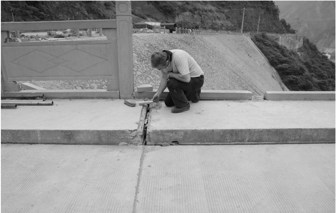
Εικόνα 4: Διαφορική κατακόρυφη μετατόπιση του σώματος του φράγματος κατά 20cm στο αριστερό άκρο.
