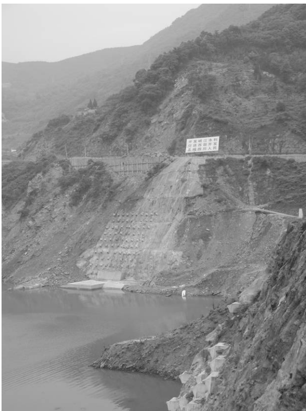
Εικόνα 10: Άποψη πρανούς, το οποίο αστόχησε παρά τα εκτελεσθέντα έργα σταθεροποίησης.
