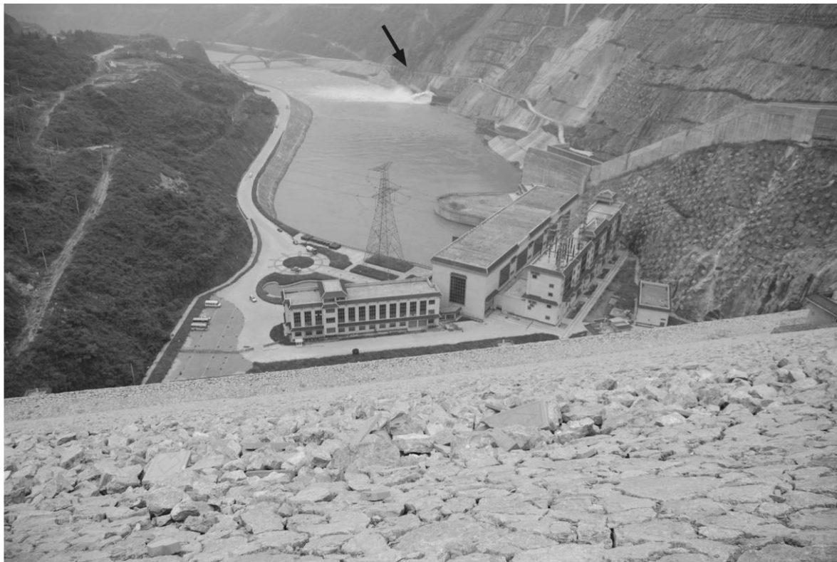
Εικόνα 3: Άποψη του κατάντη αντερείσματος του φράγματος με εμφανή αποδόμηση των όγκων επικάλυψης. Διακρίνεται η υδροηλεκτρική μονάδα και ο εκκενωτής που βρίσκεται σε λειτουργία (βέλος).
