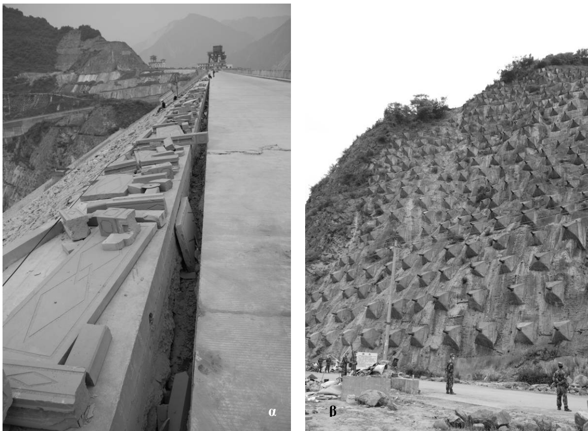
Εικόνα 8: Επιμήκης διάρρηξη μήκους 300 και πλέον μέτρων, η οποία είχε μέγιστο εύρος περί τα 60 cm, γεγονός το οποίο φανερώνει μια αντίστοιχη παραμόρφωση με όλο το σώμα του φράγματος (α). Άποψη του αριστερού πρανού στον άξονα του φράγματος το οποίο είχε οπλιστεί με πυκνό κάναβο αγκυρίων, διακρίνεται στο κορυφαίο τμήμα η κατάρρευση ογκολίθων (β).
