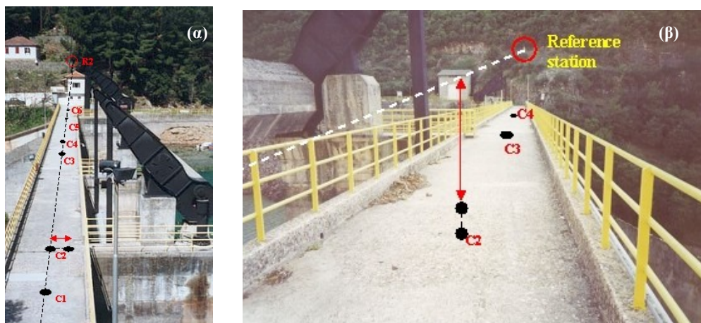
Σχήμα 1. Σχέδιο της αρχής μέτρησης των (α) οριζόντιων και (β) κατακόρυφων αποκλίσεων της στέγης του φράγματος του Λάδωνα από μια ευθεία γραμμή {4}.
