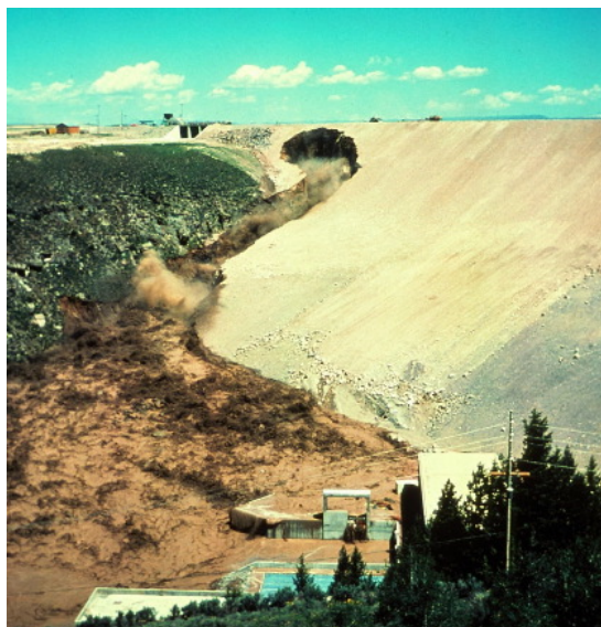
Εικόνα 1: Αστοχία του φράγματος Teton – Νοτιοδυτική άποψη. Το χάσμα έχει διευρυνθεί σημαντικά και παρατηρείται διάβρωση έντονη διάβρωση. Φωτογραφία από της κας Mrs. Eunice Olson στις 5 Ιουνίου 1976 ( http://www.geol.ucsb.edu/faculty/sylvester/Teton%20Dam/welcome_dam.html )
