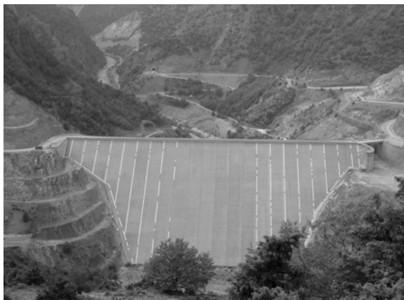
Σχήμα 1. Το φράγμα λιθορριπής Μεσοχώρας.
