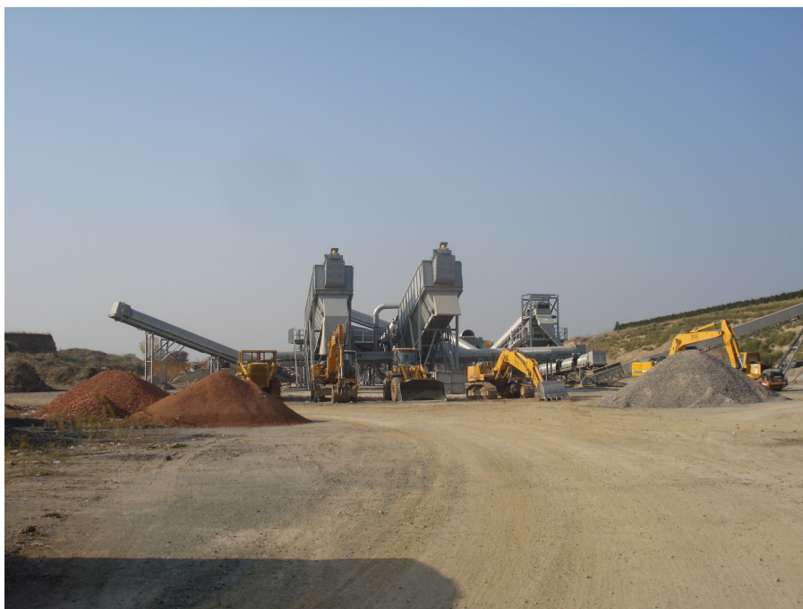
Φωτ. 3.3ζ Σημεία λήψης ανακυκλωμένων αδρανών.
