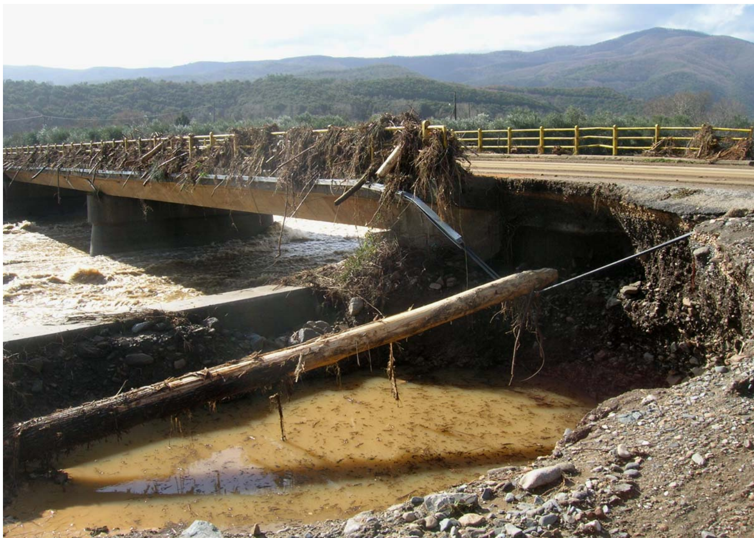
ΕΙΚΟΝΑ 7 Η υπερχειλίση του χείμαρρου σε γέφυρα του οδικού δικτύου της εγγύς περιοχής δεικνύει υπερύψωση της στάθμης υδάτων >3\text{m} κατά τις βροχοπτώσεις της 10 ης Φεβρουαρίου 2010 (Πηγή φωτογραφίας: Αρχείο Δήμου).
