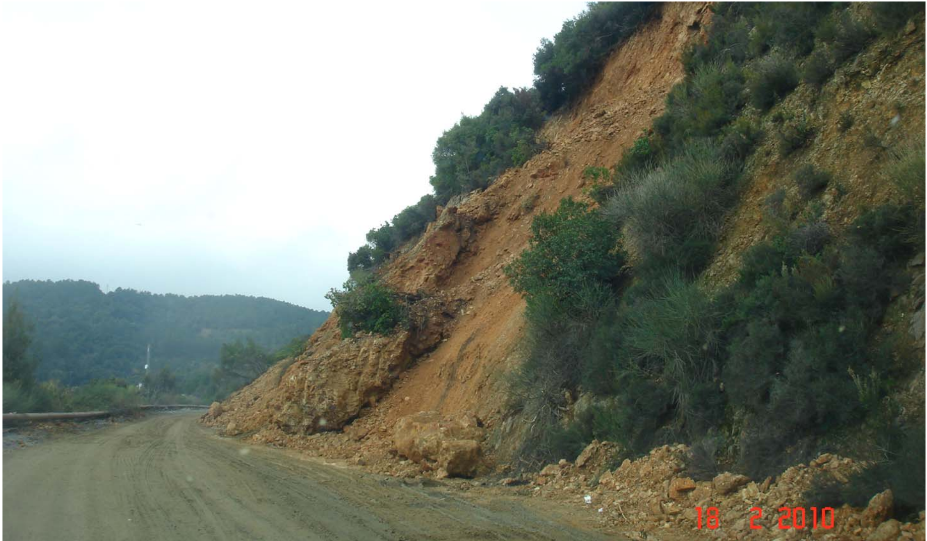
ΕΙΚΟΝΑ 5β Τυπική κατολίσθηση πρηνούς ορύγματος οδού.
