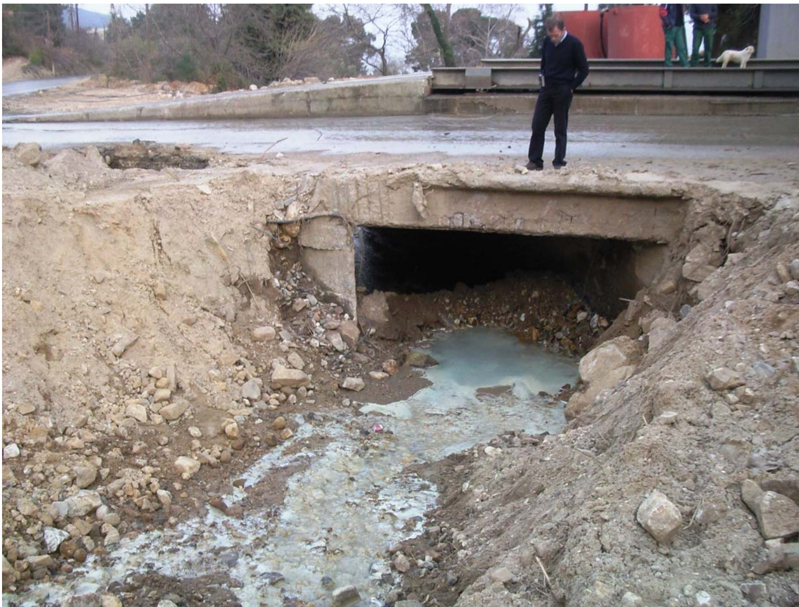
ΕΙΚΟΝΑ 11. Ο πλακοσκεπής οχετός που λειτουργούσε ως είσοδος της αντιπλημμυρικής τάφρου στην περιοχή της γεφυροπλάστιγγας
