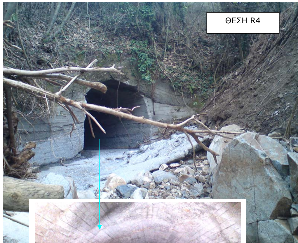
(α) Απόφραξη κλειστού οχετού ομβρίων σε θέση του οδικού δικτύου.
