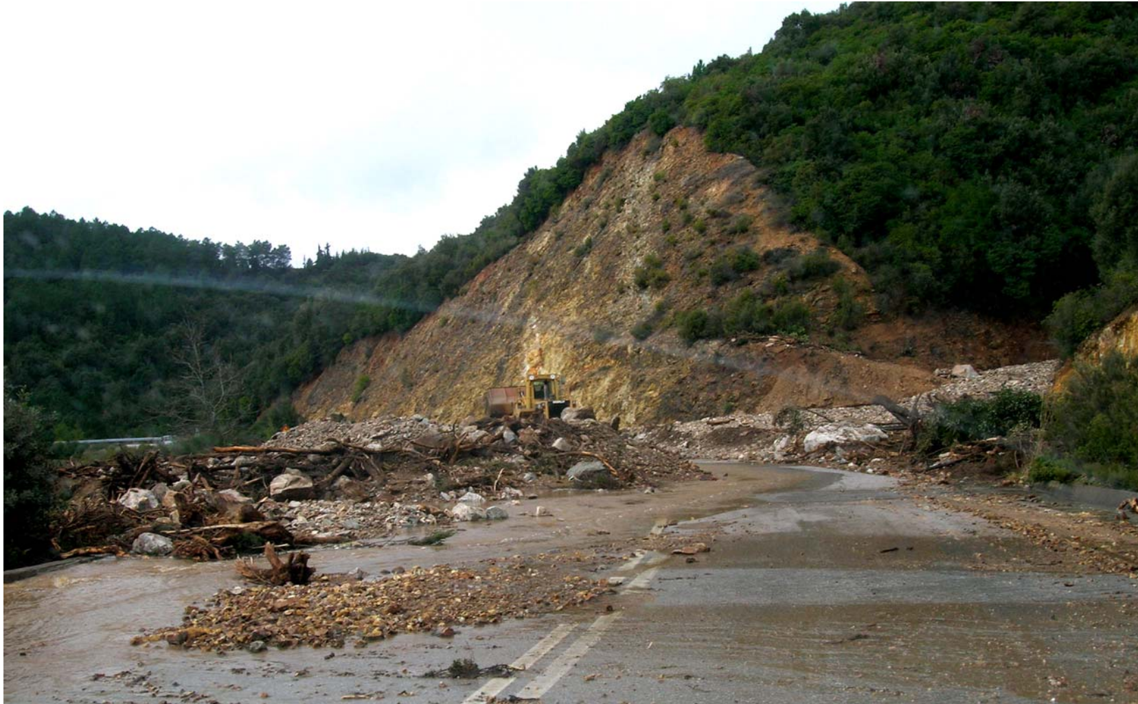
ΕΙΚΟΝΑ 3.5α Θέση R5 - Απόθεση υλικών επί της επαρχιακής οδού διερχόμενης από τη θέση του δευτερεύοντος υδατορεύματος «Αργυρώ» (Πηγή φωτογραφίας: Αρχείο Δήμου).
