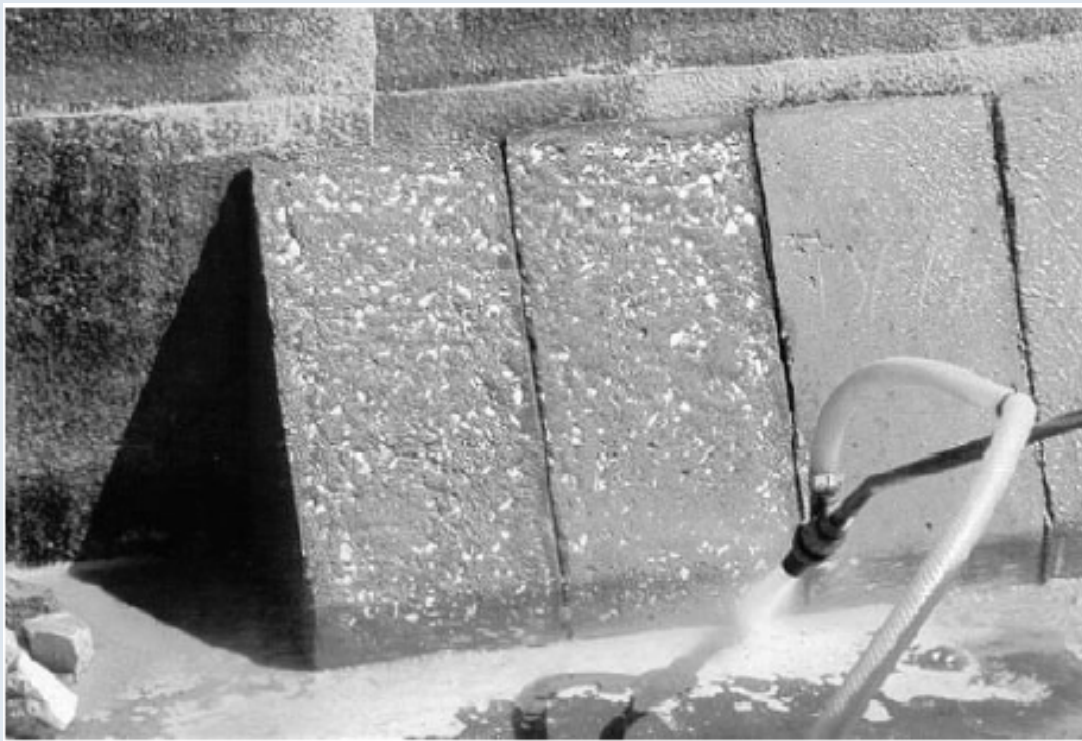
Εκτράχυνση με Αμμοβολή
