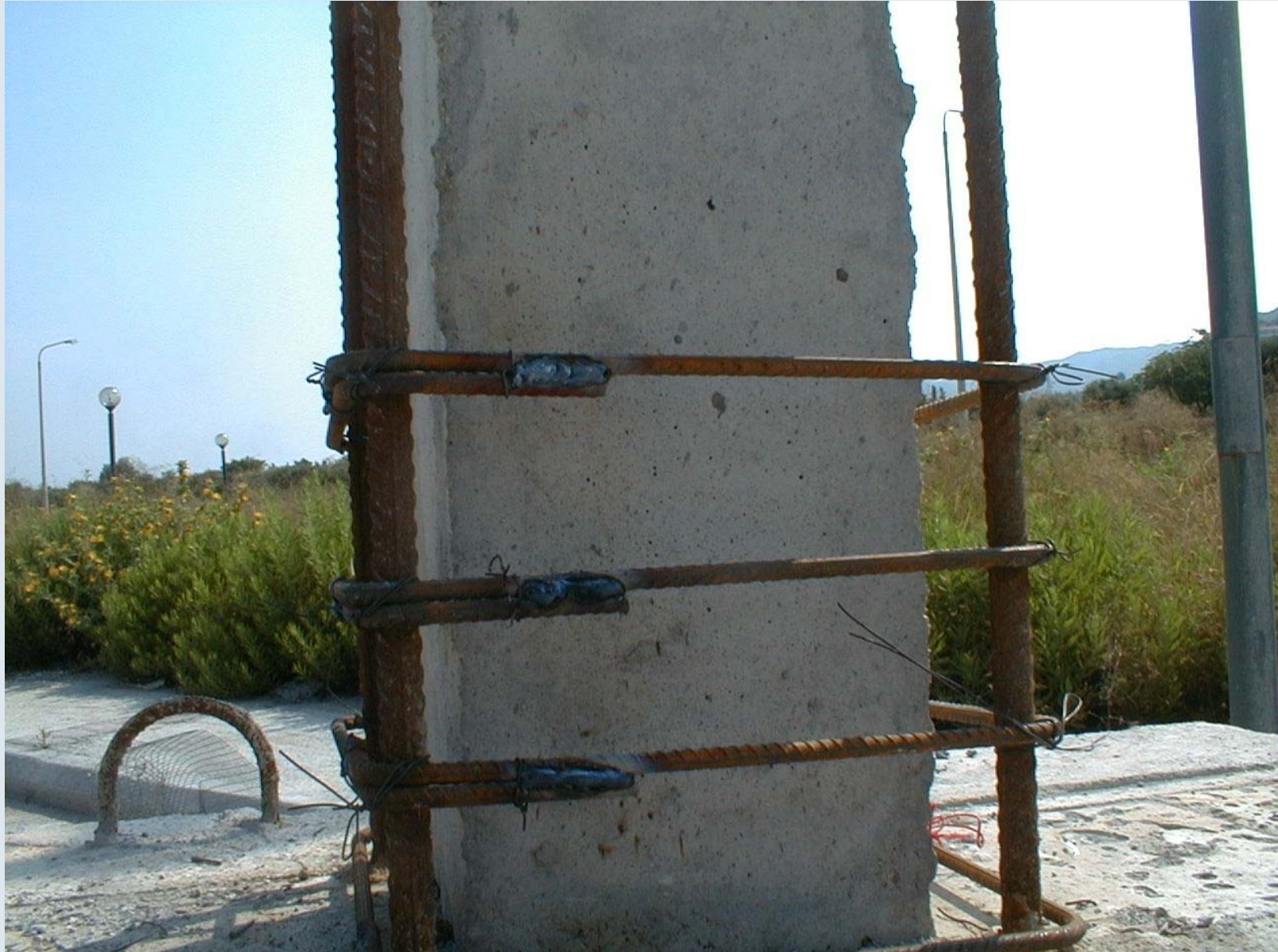
Ηλεκτροσυγκόλληση Άκρων Συνδετήρων Μανδύα 19
