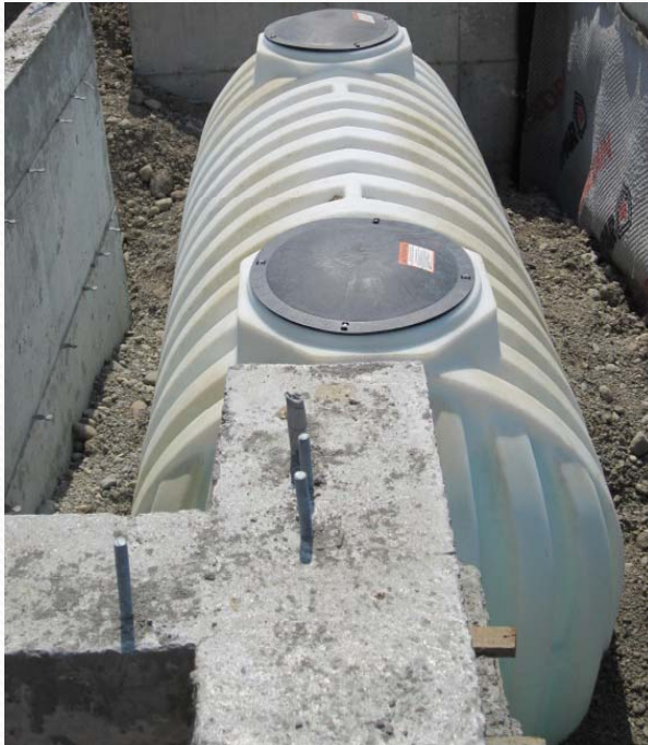
z-home.org Υπόγεια τοποθέτηση δεξαμενής
