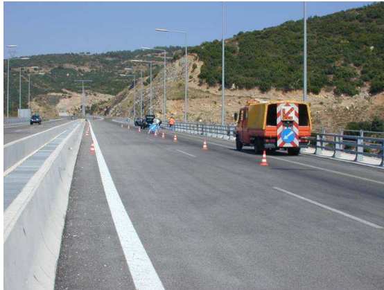
Σχήμα 9. 6. Μέτρα ασφαλείας κατά τη διάρκεια των εργασιών στη γέφυρα.
