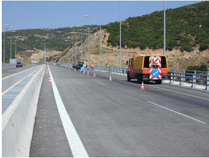
Φωτ. 6.1 Μέτρα ασφαλείας κατά τη διάρκεια διεξαγωγής μετρήσεων σε γέφυρα.
