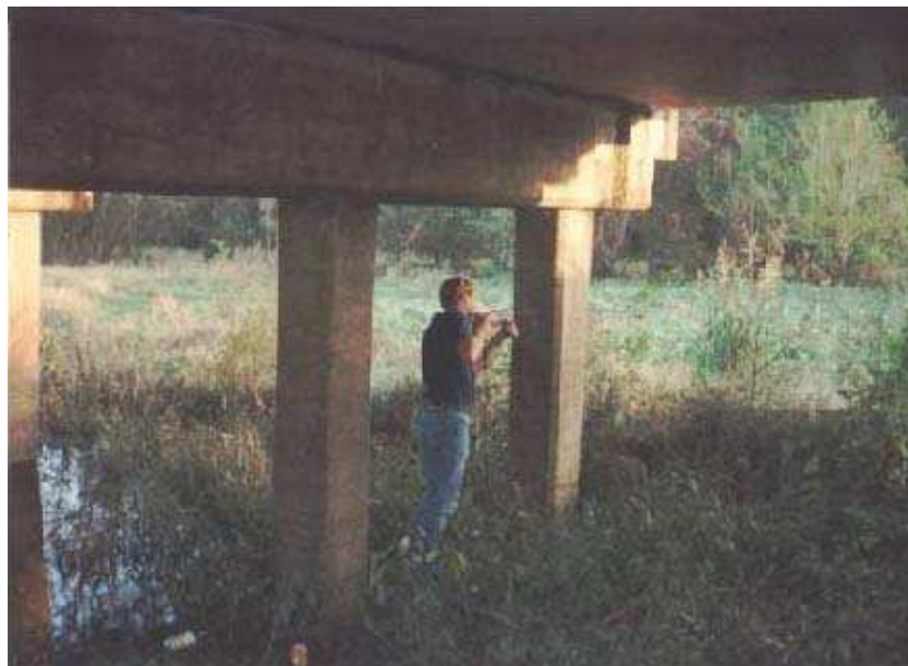
Σχήμα 7.10. Διάνοιξη οπών στο σκυρόδεμα για την εγκατάσταση σεισμικών επιταχυνσιομέτρων (Trinity River Relief Bridge).
