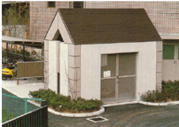
Εικόνα 1.2 Waste Collection Facilities
