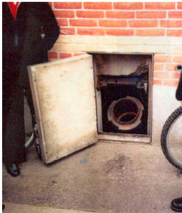
Εικόνα Γ34. Θύρα αναρρόφησης για την έξοδο των απορριμμάτων από τη δεξαμενή συλλογής.
