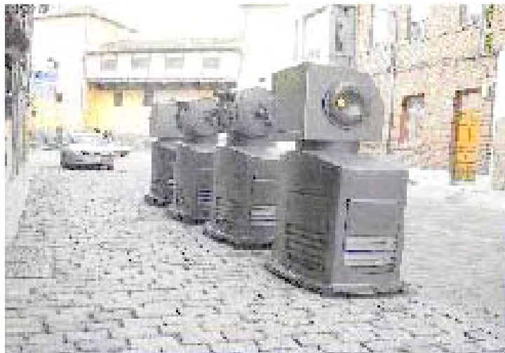
Εικόνα 1.35 Σύστημα συλλογής με πεπιεσμένο αέρα στο Ιστορικό κέντρο της Λεών
