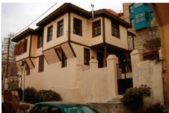
Εικόνα 9: Διατηρητέο κτίριο επί της οδού Τυρταίου στην Άνω πόλη Θεσσαλονίκης (Κήρυξη ΥΜΑΘ). (Πηγή: αρχείο Ο.Ε)
