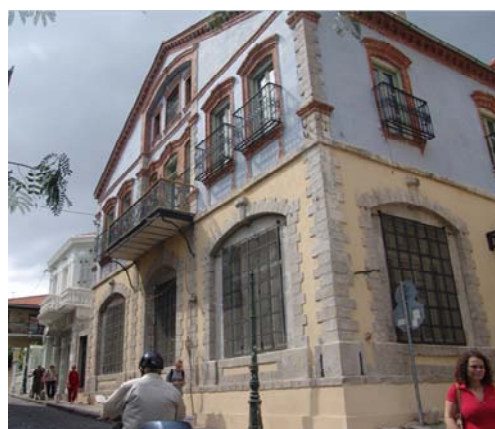
Εικ. 16. Το διατηρητέο κτίριο του παλαιού Ταχυδρομείου, στην οδό Βενιζέλου στην Ξάνθη (κήρυξη ΥΠΠΟ, ΥΜΑΘ). (πηγή: αρχείο Ο.Ε)
