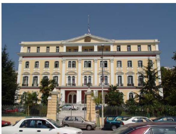
Εικόνα 1. Το διατηρητέο κτίριο του Διοικητηρίου (Υπουργείο Μακεδονίας Θράκης) στη Θεσσαλονίκη (πηγή: αρχείο ομάδας εργασίας).
